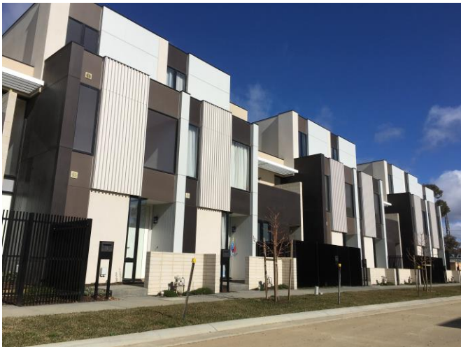
上图：第一期联排别墅及其环境美化项目均已完工
