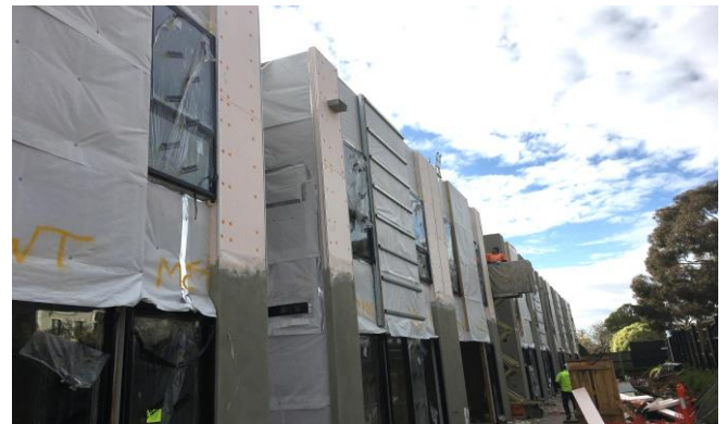
上图：正在进行联排式房屋的外包层工程
