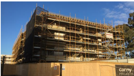
上图：为窗户和外包层工程而架设的脚手架
